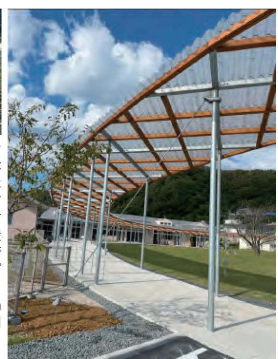
【講評】千葉県郊外の道の駅拡張に伴い、2つの施設を連結する大きな広場を囲うように設けられた屋外回遊路である。風景と調和させながら人々の活動を循環させるように、おおらかな自由な円環状の回廊は、活動を妨げないように最小限の部材で構成されている。高さが2.7m～5.7mと傾いた円形屋根はφ114.3mmの鋼管柱で支持され、最小限のバックスティをとることで水平剛性を調節している。屋根はスパン1.2mの格子梁として、柱同士をつなぐ120mm角型鋼管の間を120mm角の木格子梁を架けて、2方向支持とするためレシプロカル構造とし、回廊両端の縁梁により全体の面剛性を確保している。木と鉄を適材適所に組み合わせて用いることにより、すべて120mm角で外形が統一されたシンプルな架構を合理的に実現している。特別な技術や特殊な部材を用いることなく、肩に力を入れず、さりげなくシャープな架構を実現していることに好感が持てる（陶器）
