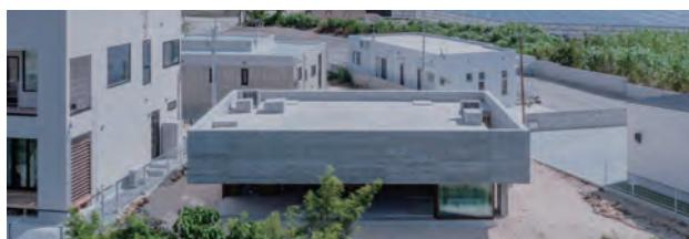
【講評】最初にこの計画を見たときにまず沖縄の家であることに驚かされた、沖縄の家は台風が多いため、堅牢な RC の箱型の建築を思い浮かべるからである。この計画はそれを「裏切る」挑戦的なデザインである。ただ沖縄の伝統的な民家の深い軒の屋根のような「守られた」居場所をこの家は RC の巨大なキャンチレバーで作り出していることに驚くが風除けの扉がないのは気になる。特徴的なのは、深く垂れ下がった軒の壁と全面的に開け放てる引き戸がより一層守られた居場所を内部に作り出していることである。気になったのは一本足の矩形の柱が、主な構造であるが、サブの柱が隠されていること、水回りの配置に工夫が欲しかったことである。沖縄の建築の新たな挑戦として入賞にふさわしい計画であるといえよう。（堀越）
