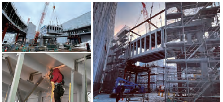
北海道の鉄鋼技術をもつ職人の手による「スチールモノコック」の構造体を実現
